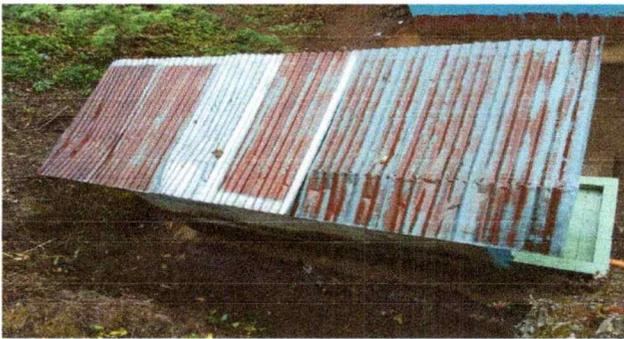
Foto 3: SE OBSERVA EL TECHO DE LOS SANITARIOS QUE ESTA EN MAL ESTADO
